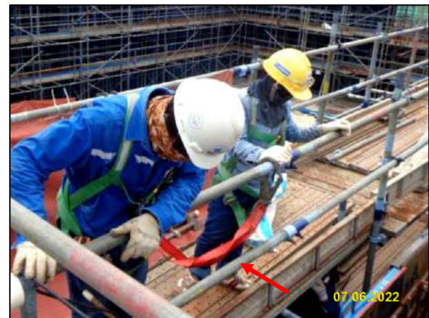
ข) อุปกรณ์ป้องกันการตกจากที่สูงขณะปฏิบัติงาน
